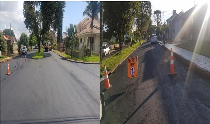
Fiscalização do início do reperfilamento na Av. Afonso Botelho. Este serviço visa uma regularização na pavimentação, para posterior execução do recape asfáltico.
