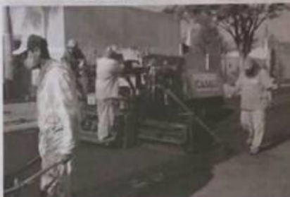
Entre as obras visitadas está a de recape, entre as Avenidas Goleorê e Manoel Mendes de Camargo
